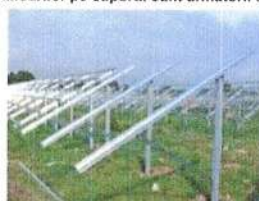
Montare rame pe piloni
