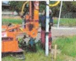
Montare piloni de susținere
