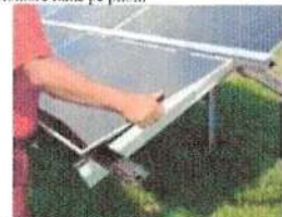
Fixare panou fotovoltaic pe șinele de susținere
