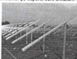
Montare rame pe piloni
