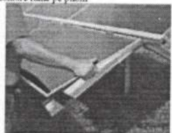
Fixare panou fotovoltaic pe sârmă de susținere
