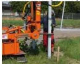
Montare piloni de susținere
