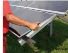
Fixare panou fotovoltaic pe sinele de susținere
