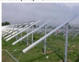
Montare rame pe piloni
